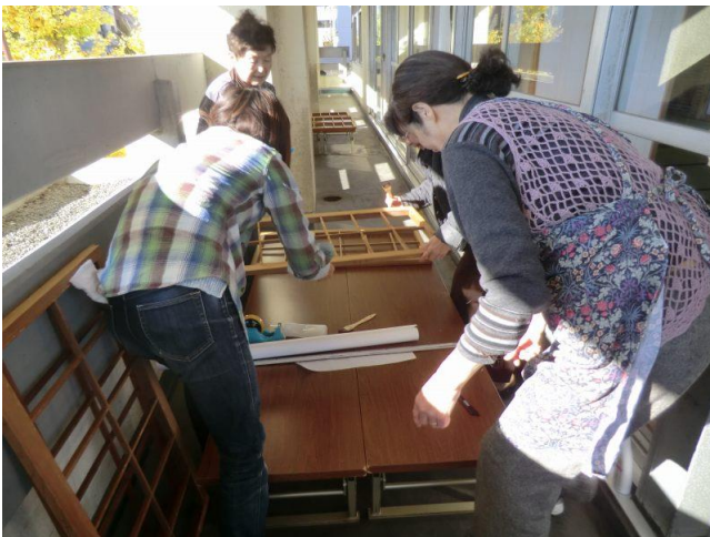
2階茶室の障子張り
